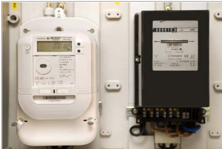
Abbildung 4: Smart Meter (links), Ferrariszähler (rechts) - Quelle: http://e-control.at
